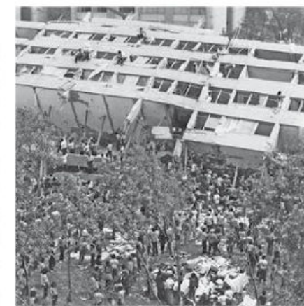
5.11 Daños provocados por el terremoto de 1985.
